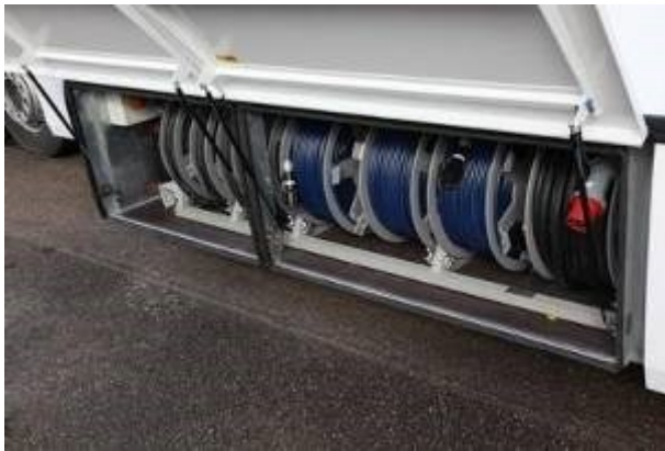
RK – kablovi za napajanje, tonski i video kablovi
